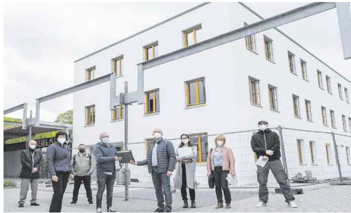
Das Paul-Löbe-Haus in Pforzheim: Alle Holzbauteile müssen aus Brandschutzgründen mit Gipsfaserplatten ummantelt sein.
